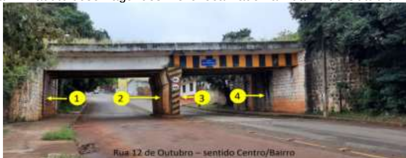
Figura 1: Viaduto José Fagundes Mello localizado na Rua 12 de Outubro – Ijuí/RS
