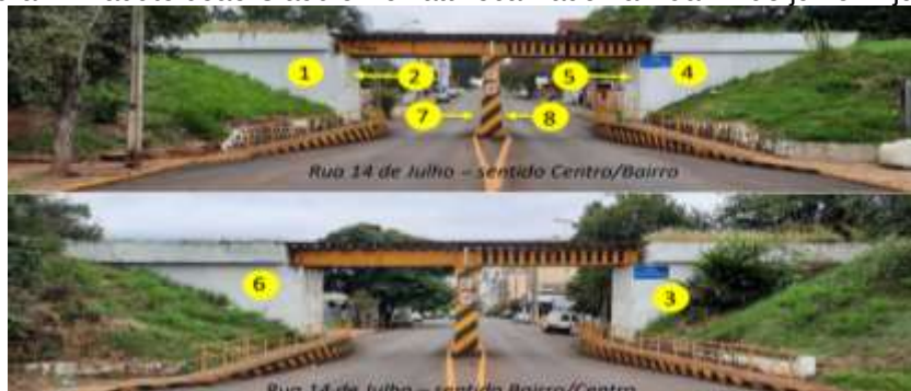
Figura 2: Viaduto João Cláudio Boniatti localizado na Rua 14 de julho – Ijuí/RS
